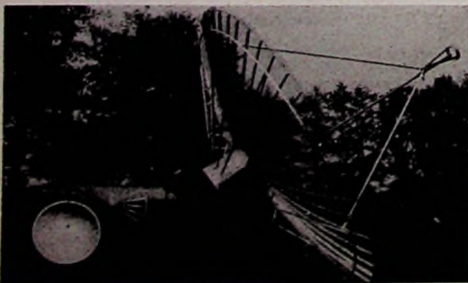
Afb. 14 Parabool-antenne gericht op het zuiden. De maximale elevatie is 30°.
